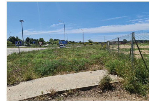
07. limit est (tanca amb carretera)
