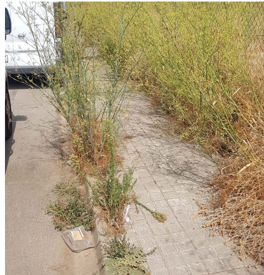
Imatge 4. Aflorament de vegetació al contacte entre panot i peça de vorada.
