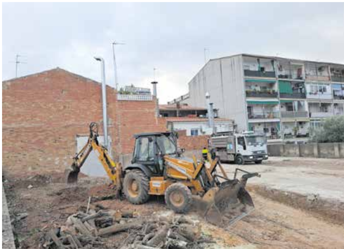
Les obres del pàrquing, que està situat a la cruïlla entre els carrers de les Llagostes i Josep Girbau i Homet. || AJ. CASTELLAR
