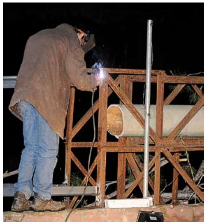
© Un operari reparant la canonada que es va trencar a l'Airesol D. || J.G.
