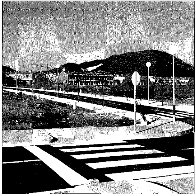
Un dels futurs carrers residencials del Pla de la Bruguera i que recentment s'ha urbanitzat.
