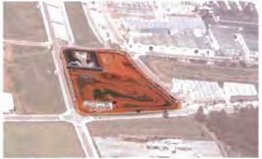
El futur centre especial de treball es construirà dins d'aquesta parcel·la municipal de 17.000 m 2
