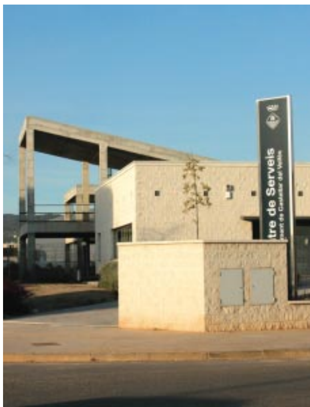
Vista actual de l'edifici amb la part per on s'ampliarà al fons.
