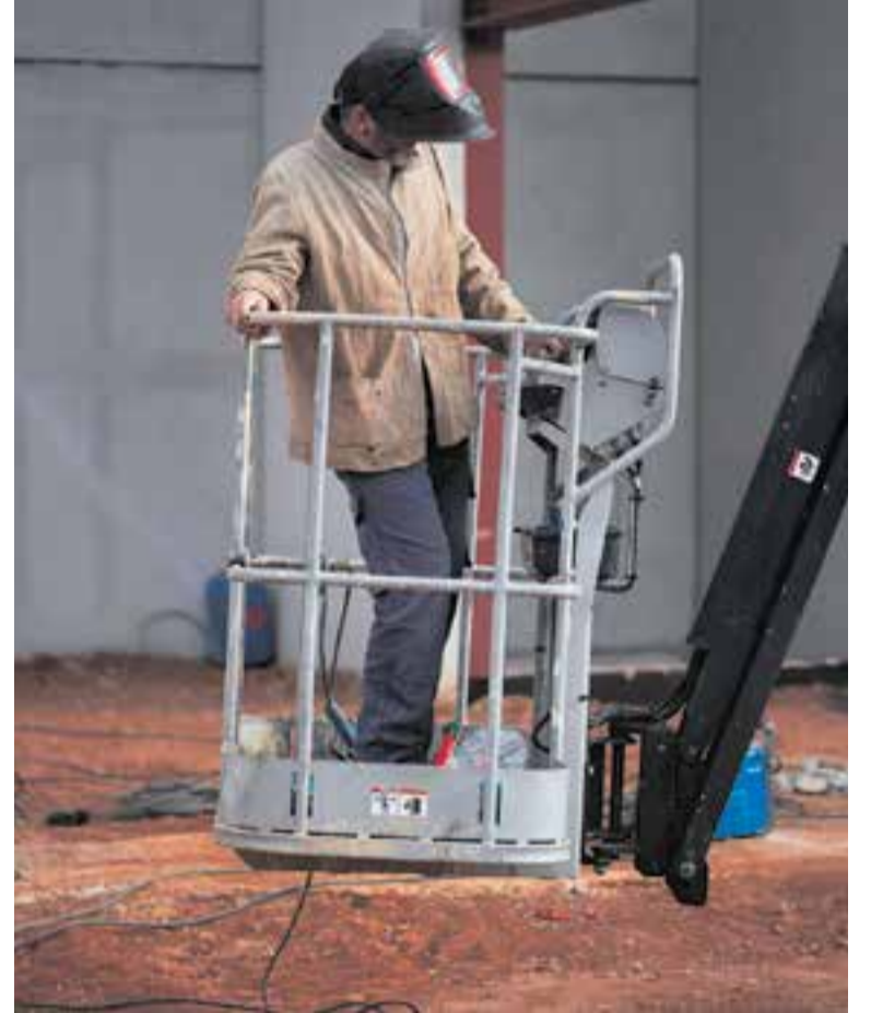
Un operari treballa en la construcció d'una nau industrial al Pla de la Bruguera. || Q. PASCUAL
