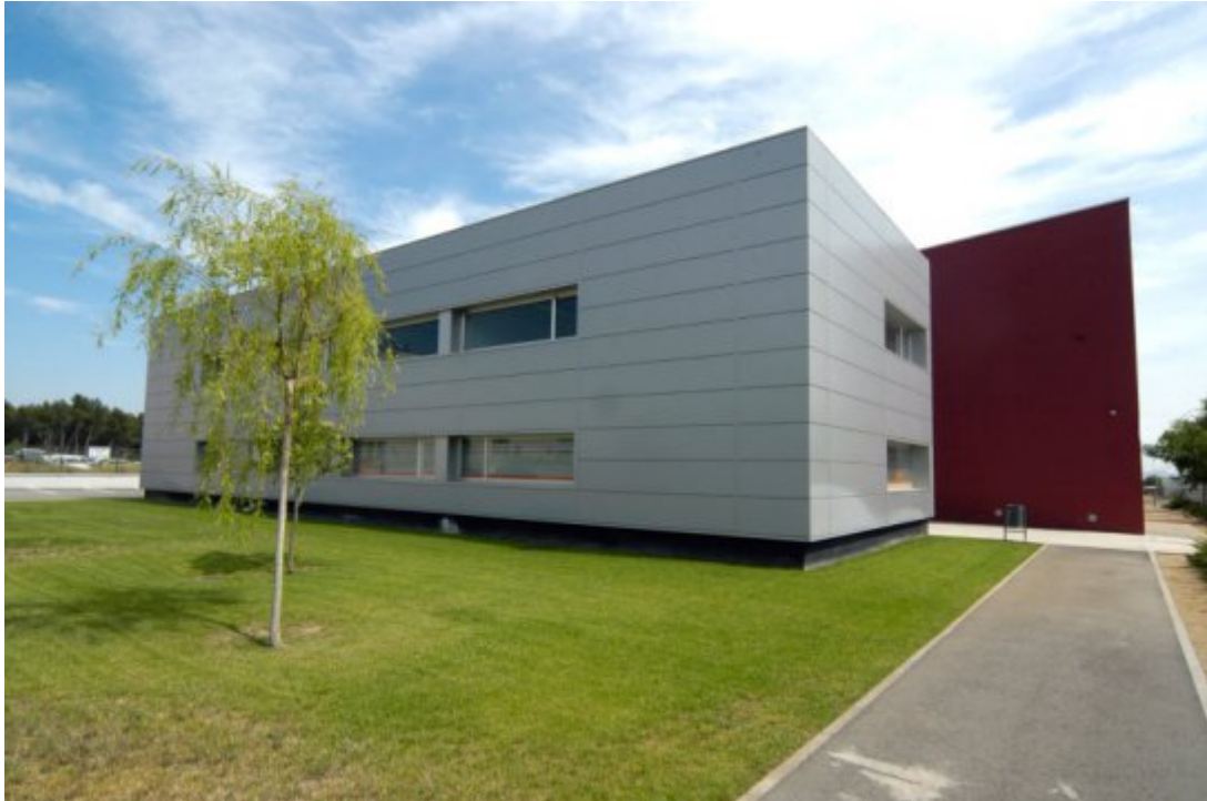
Centre de Serveis 1
