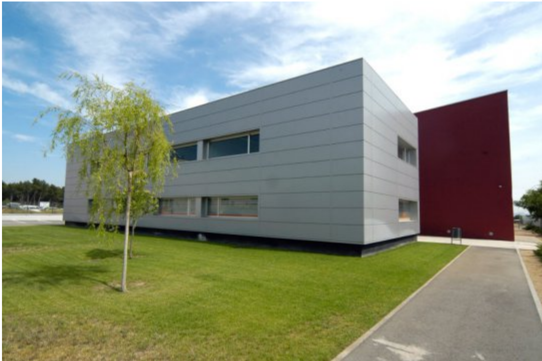
Centre de Serveis 1
