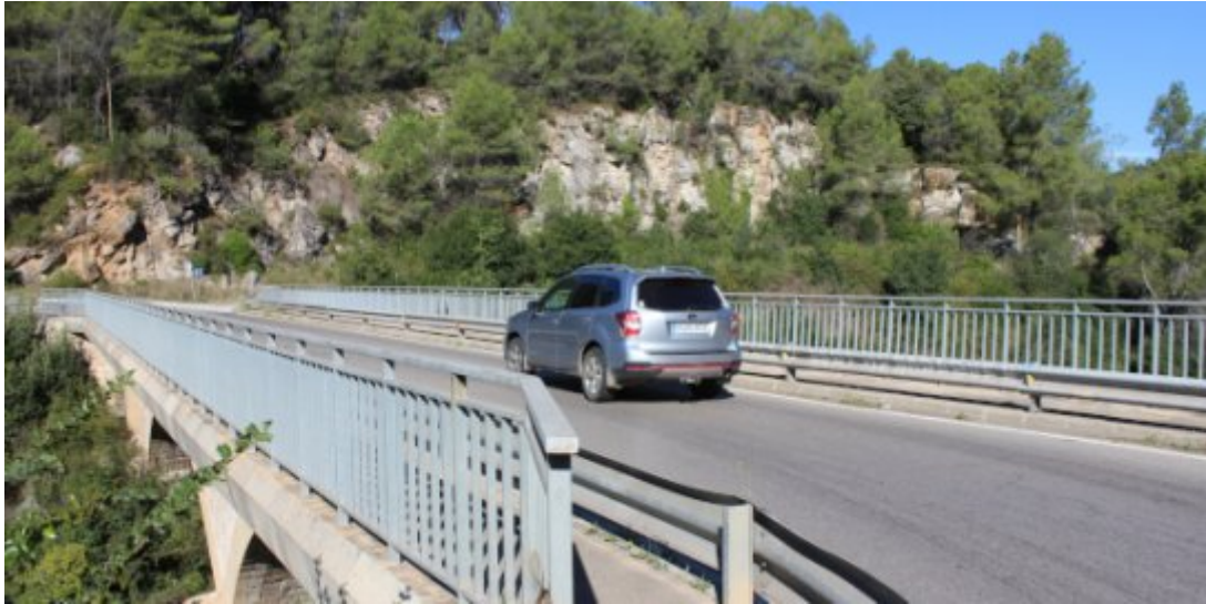
Pont de Sant Feliu del Racó a la carretera BV-1249.
