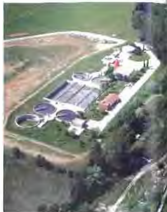
Depuradora del riu Ripoll
